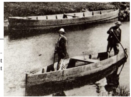
Ce détail d'une carte postale de l'écluse de Rozé illustre bien la différence entre un blin, monté à clins, et un petit chaland à un seul bord. Les constructions sont analogues mais le blin est plus porteur. Col. Part.
